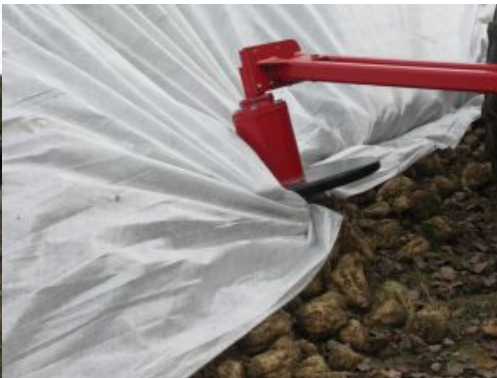
... und anschließend maschinell abgerollt.
